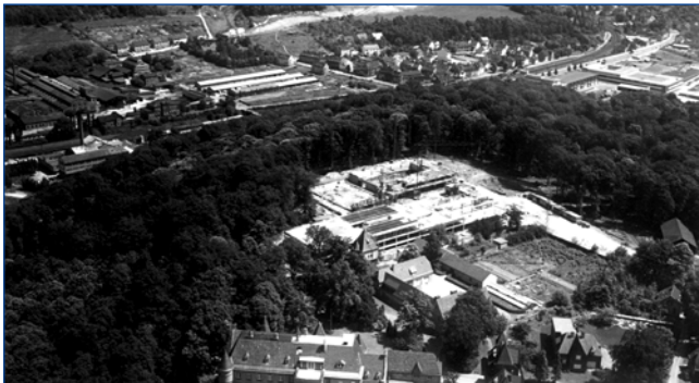
Luftaufnahme des Halbergs mit Blick auf den Bau der Sendergebäude (ca. 1961)
